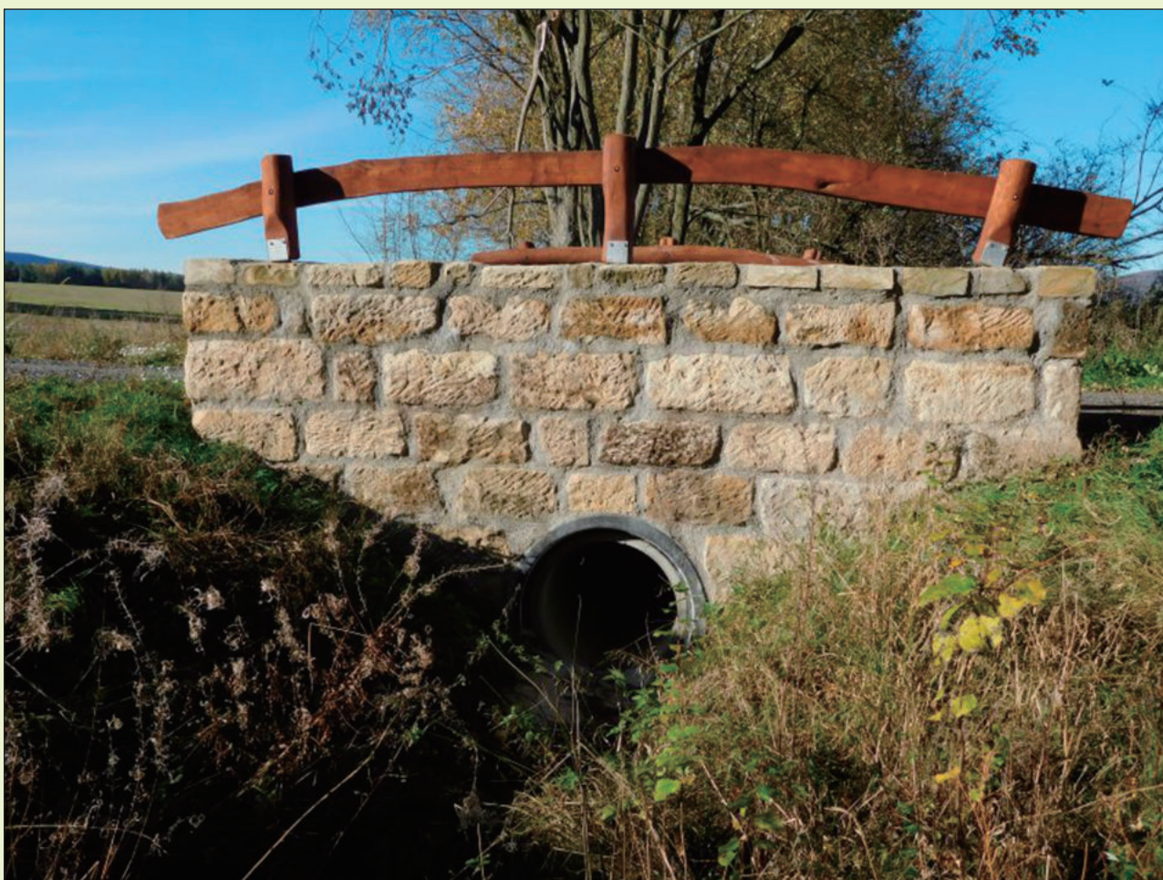
Velmi citlivé provedení propustku s použitím přírodních materiálů
