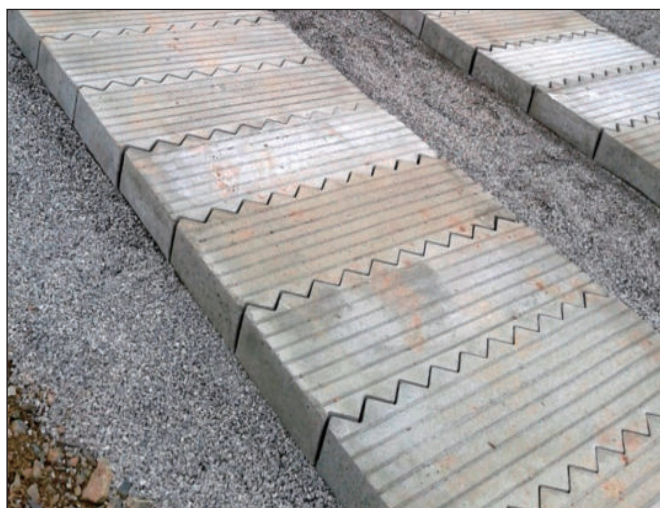
Obrázek 2: Nové betonové prefabrikáty široké 1000 mm
