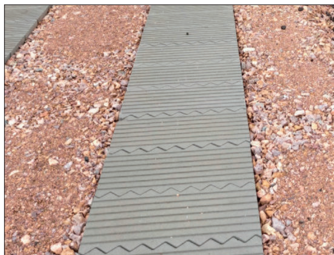
Obrázek 1: Používané betonové prefabrikáty široké 800 mm
